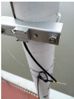
图 5 安装于 JB01 拉索的双向加速度计
