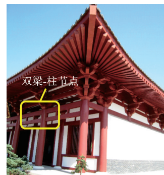
图 1 传统风格建筑双梁-柱节点
