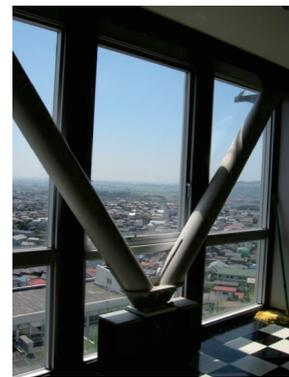
图3 油阻尼器支撑系统
