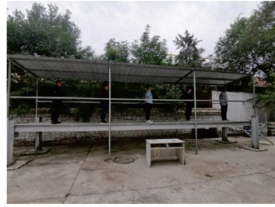
图 9 均布荷载工况测试图
