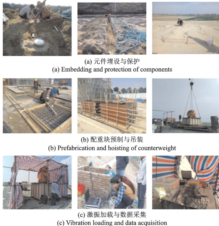
图 2 现场激振试验测试过程图
