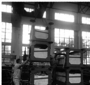
图4 更换工况作业
