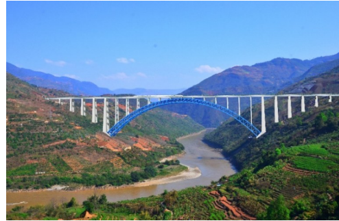
图 4 怒江特大桥实景图
