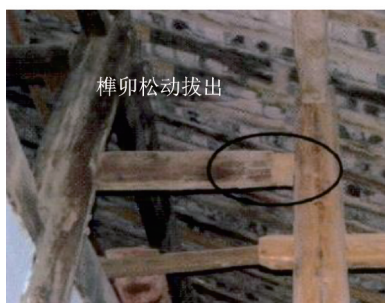
(b) 榫卯松动 (b) Looseness of mortise-tenon
