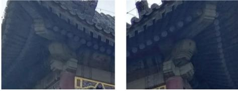
图 8 北宫门木结构中的斗拱节点
