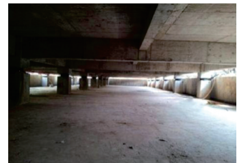
图4 隔震检修层 Fig. 4 Isolation overhaul layer
