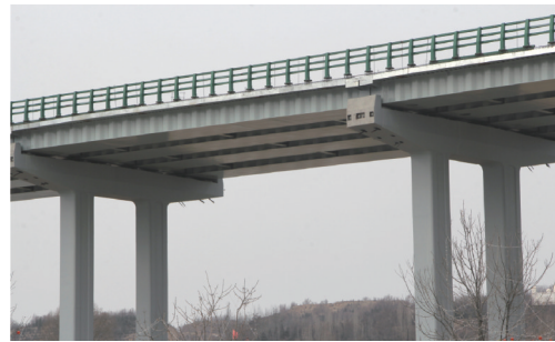
图6 改进型波形钢腹板组合简支箱梁
