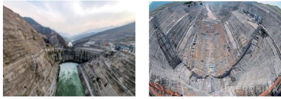
(a) 工程概貌 (a) Project overview (b) 爆破开挖图 (b) Blasting excavation drawing
