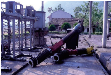
图 2 开关设备的根部破坏
