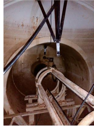
图6 假海筒内钢柱结构
